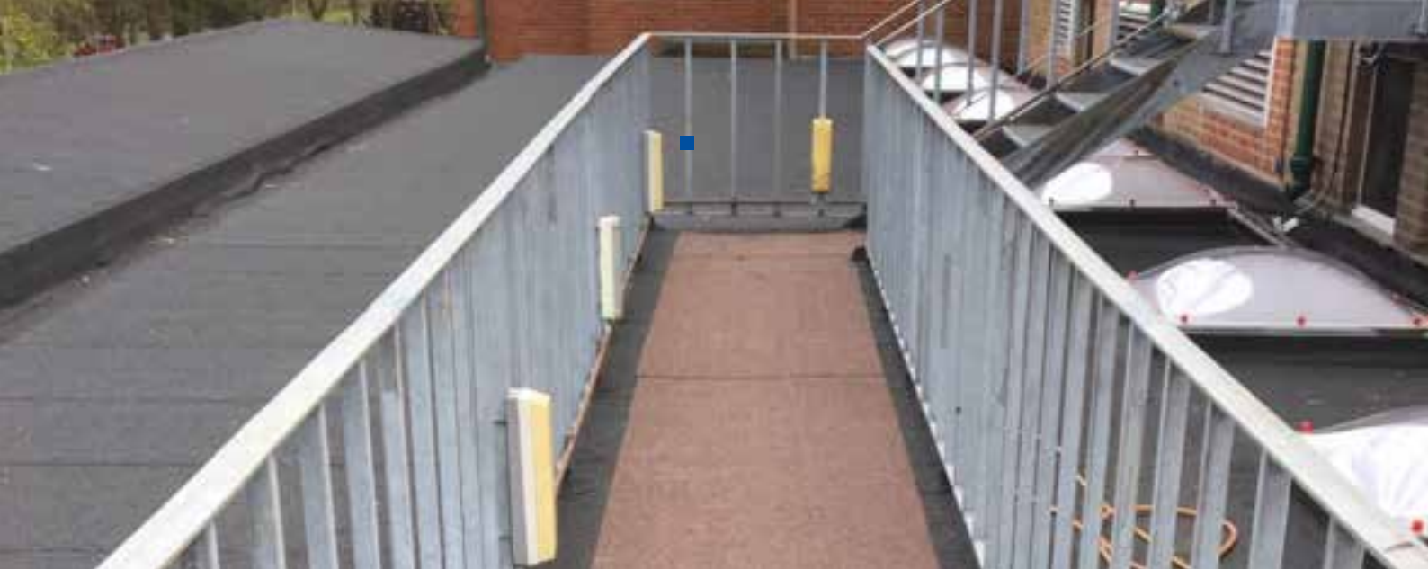
La toiture est praticable
