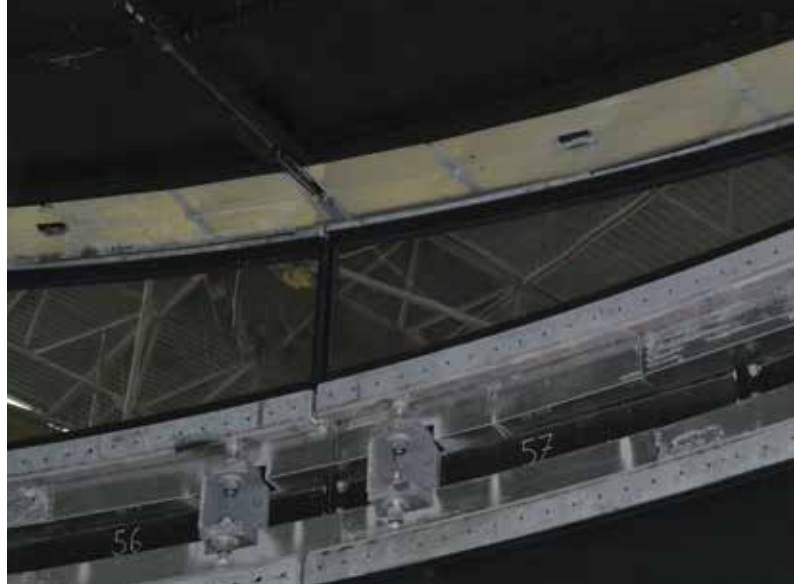
La structure porteuse
